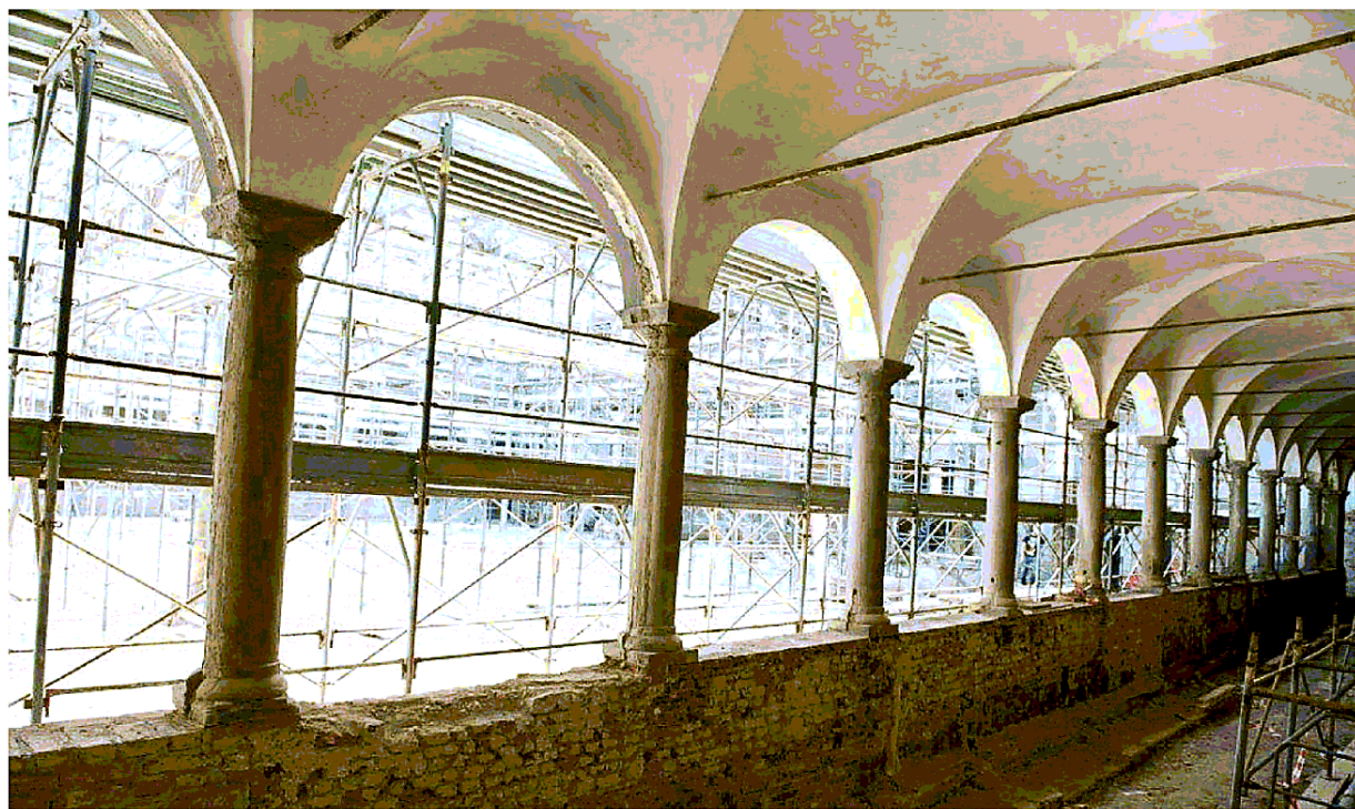
Lavori al primo piano dell'ex Manifattura tabacchi
